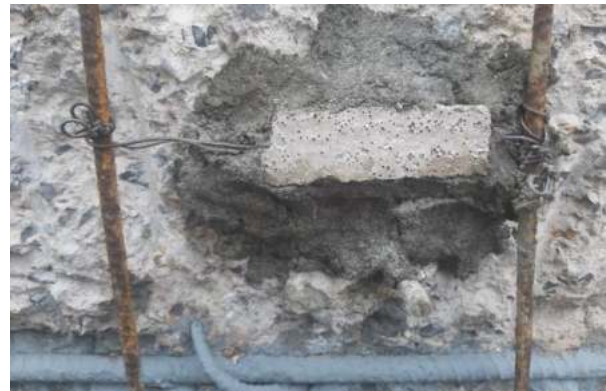
प्रबलित कंक्रीट के कैथोडिक संरक्षण पर अनुसंधान और विकास परियोजना के तहत क्षेत्र अध्ययन के लिए स्थल पर बलि एनोड की स्थापना
