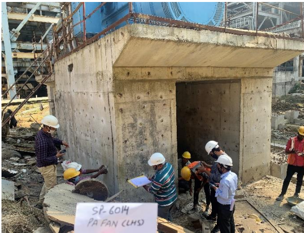
UPV Test on ID Fan Foundation
