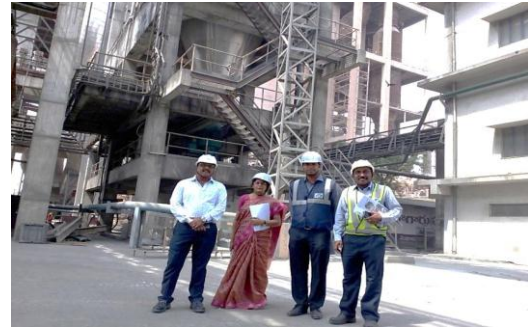
एनसीबी –एच टीम द्वारा सीमेंट प्लांट का निरीक्षण
