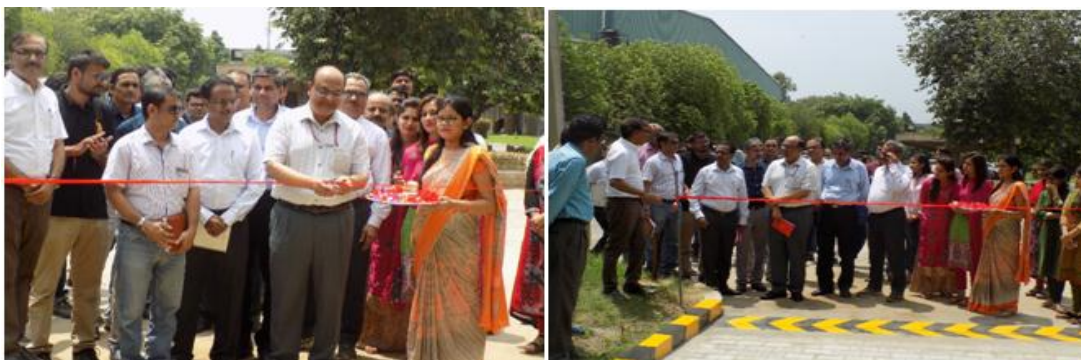
श्री अनिल अग्रवाल, संयुक्त सचिव-डीपीआईआईटी द्वारा एनसीबी-बी में जियोपॉलिमर कंक्रीट इंटरलॉकिंग पेवर ब्लॉक का उपयोग करके लगाए गए ट्रायल पेवमेंट स्ट्रेच का उद्घाटन
