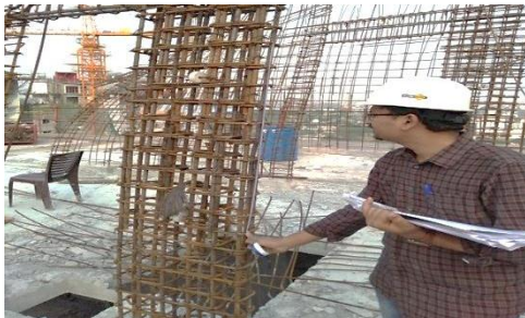
आईआईटी मद्रास कैंपस में एक कॉलम के लिए प्रदान की गई लप की लंबाई की जाँच
