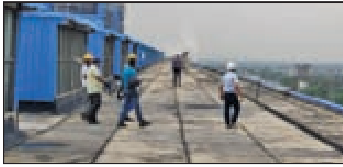
एनटीपीसी सिपट में एनसीबी टीम द्वारा टीजी रूफ स्लैब टॉप का निरीक्षण
