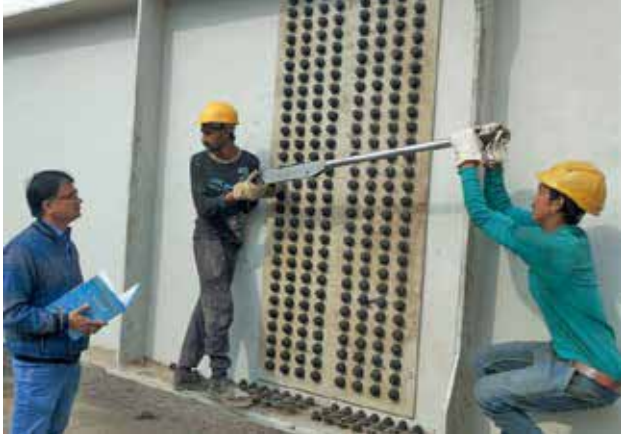
विकासपुरी, दिल्ली में पीडब्ल्यूडी फ्लाइंगोवर परियोजना में एचएसएफजी बोल्ट के टार्क की जांच
