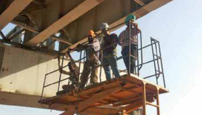
विकासपुरी, दिल्ली में पीडब्ल्यूडी फ्लाइंगोवर परियोजना में स्लैब कंक्रीट के बाद एचएसएफजी बोल्ट का निरीक्षण
